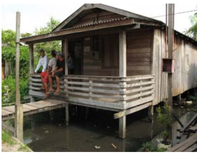
Agua estancada debajo de una casa
